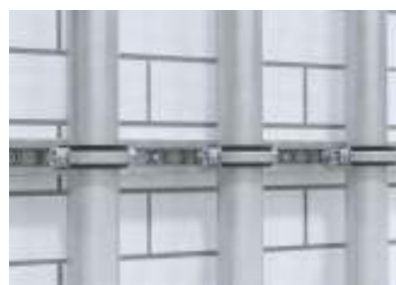
Kotvení vodovodních rozvodů
