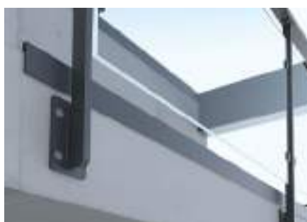
Kotvení zábradlí
