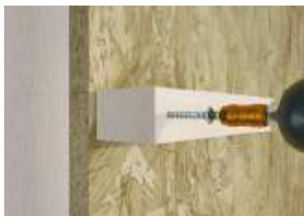
Montáž instalačních profilů
