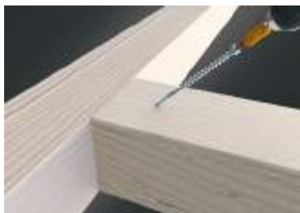
Spojování hlavních a vedlejších nosníků
