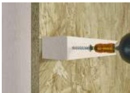
Montáž instalačních profilů
