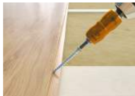
Montáž podlahových prken
